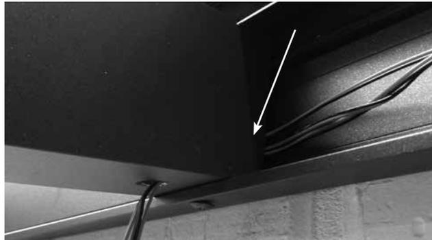
Bohren Sie **unten in die Träger** (D1, D2, D3, DX) wo ein Beleuchtungsprofil kommt, entlang der Wandseite.
