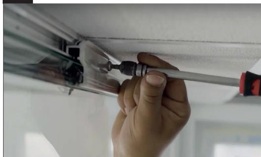
Schrauben Sie den Adapter am Deckenprofil fest.
