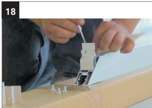
Verschrauben Sie die Verbinder rechts und links im Kopfteil der Zarge.
