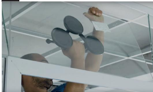
Setzen Sie das Glas leicht geneigt ein und kippen Sie es hoch, bis es gerade steht. Schieben Sie es in das H-Profil ein.
