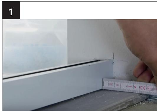
Legen Sie das Bodenprofil auf den Fußboden und zeichnen Sie den gewünschten Seitenabstand an.
