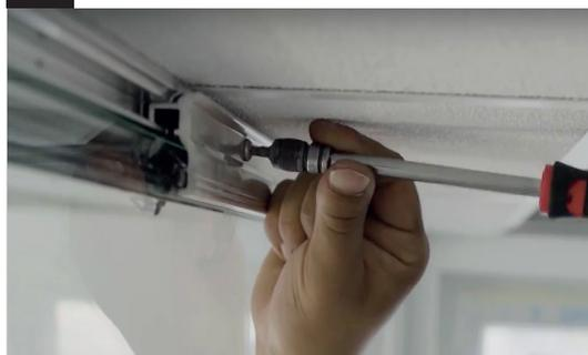
Schrauben Sie den Adapter am Deckenprofil fest.
